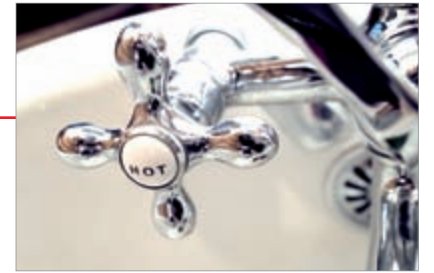
Kullanma sıcak suyu
